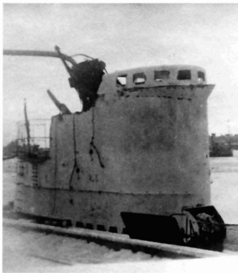
Перископ подлодки Щ-408 после столкновения с сетевым заградителем «Онега» 26 сентября 1941 г.
