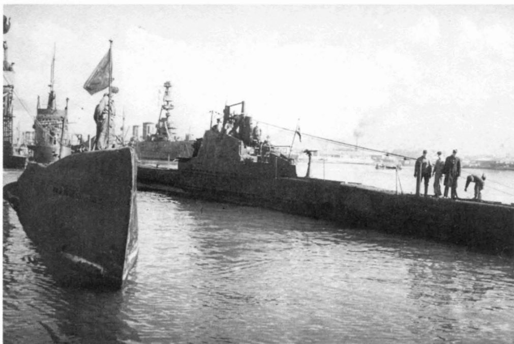
«Щуки» 2-го дивизиона Щ-209 и Щ-215 (справа). Привлекает внимание нестандартное артиллерийское вооружение последней: 25-мм автомат 84-КМ и 12,7-мм пулемет ДШК. Батуми, конец 1943 г.
