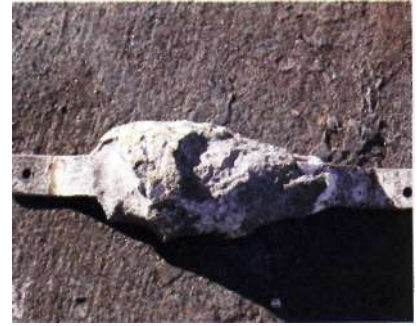
Анод, разрушенный коррозией
